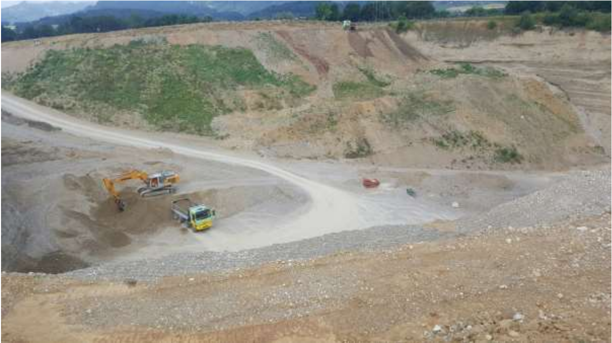
Figura 1: El emplazamiento del proyecto, una gravera de cuatro hectáreas en Losforf, cerca de Olten, Suiza
